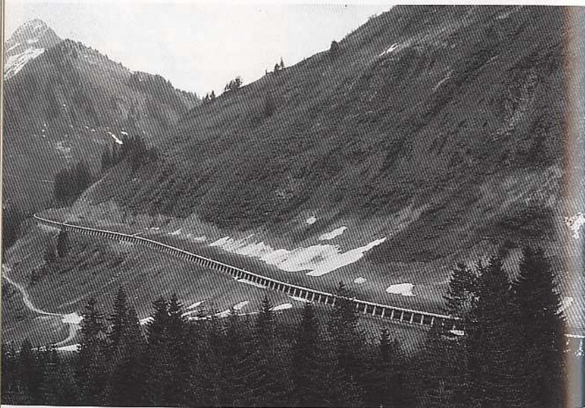
Ein Teil der 2 km langen Lawinenschutzgalerie zwischen Fontanella und dem Faschinajoch → Route 34, Rund um den Walgau. Foto Verlagsarchiv
