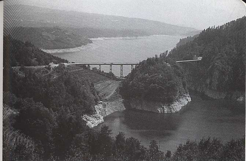
Lago di San Giustina. Blick vom Nordufer zum Ponte Viadotto → Route 73, Rund um die Brentadolomiten. Foto Harald Denzel
