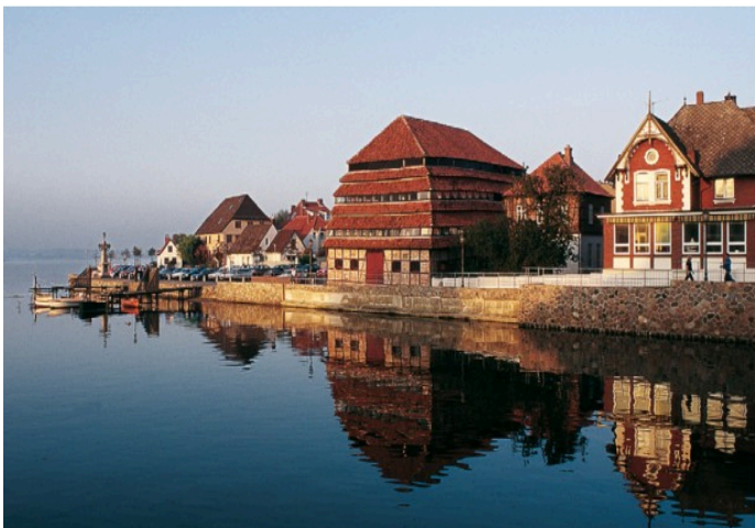
Dieser mächtige Kornspeicher in Neustadt wird wegen seines eigentümlichen Walmdachs auch Pagodenspeicher genannt.
