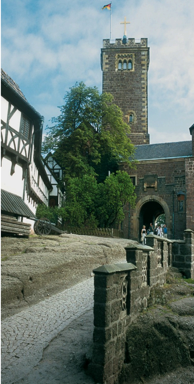
Die Wartburg in Eisenach ist eine der bekanntesten und geschichtsträchtigsten Burganlagen Deutschlands.
